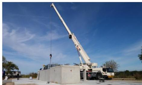
Pose des modules béton constituant la plateforme
